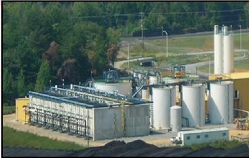
图 2 物化法装置和 ABmet 生物处理装置(美国北卡罗来纳州某电厂)
