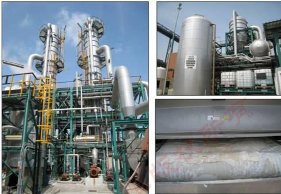
图9 脱硫废水的蒸发器,结晶器,脱水装置(意大利ENEL Brindisi电厂)
